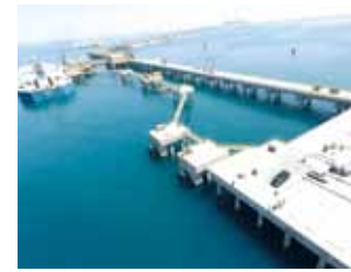
▲ 선박 접안 시설 및 제티(Jetty)
