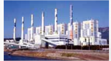
▲ 현대중공업이 참여한 하동 화력발전소 6호기 건설 현장
