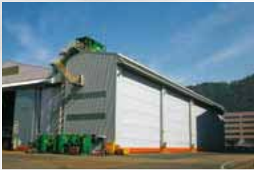
▲ 현대미포조선 도장1공장 증축
